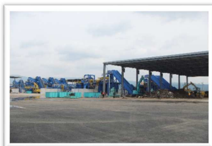
熊本県災害廃棄物二次仮置場
